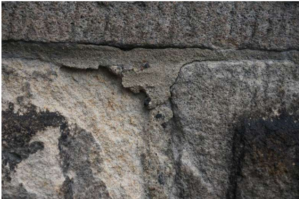
Fot 5. Wtórne spoinowania i korozja elementów murowych
