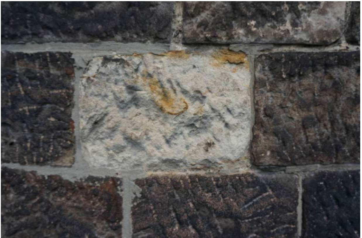
Fot 7. Wtórne spoinowania i korozja elementów murowych
